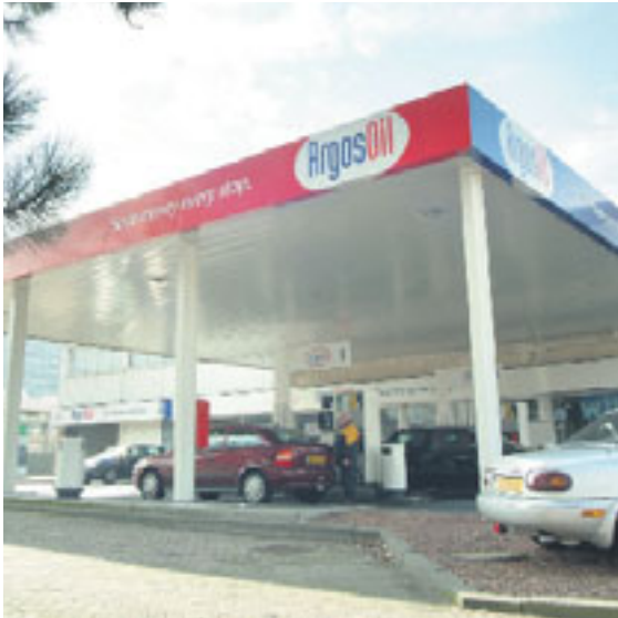
Het nieuwe parapedaarje van Argos Oil is e-fuel B5 biodiesel.
