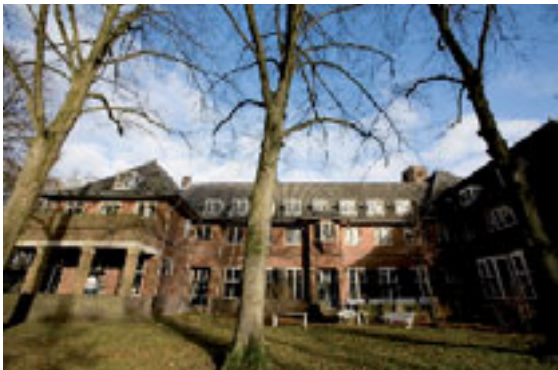
Een vleugel van het imposante gebouw.
